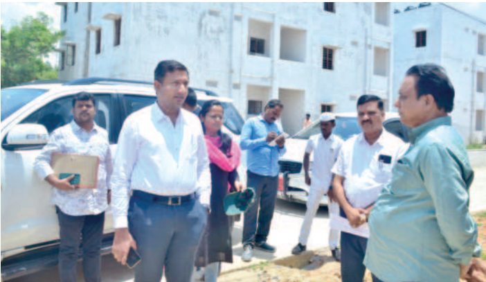
డబుల్ బెడ్ రూమ్ ఇళ్ల నిర్మాణ పనులను పరిశీలించిన కలెక్టర్ రాజర్షిషా
